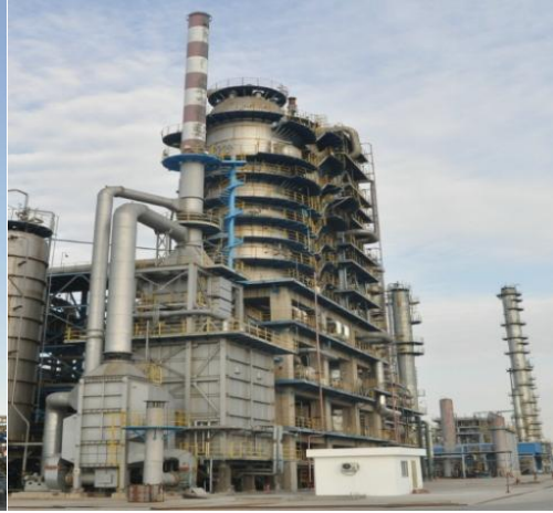
原料加热炉
