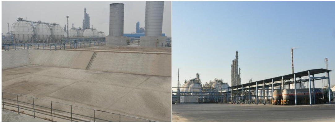
事故水池防渗措施
