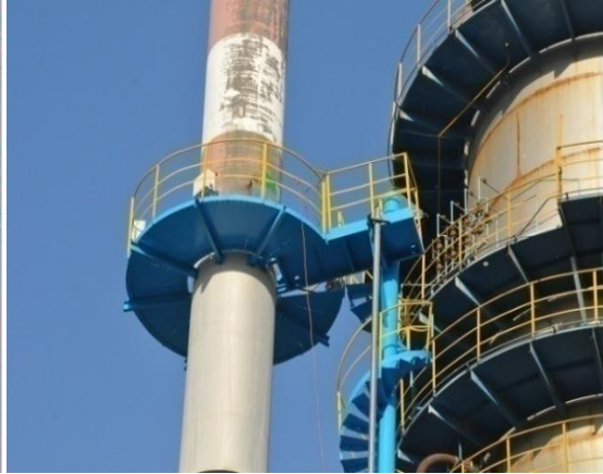
加热炉烟气排放监测平台
