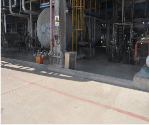
生产装置区围堰设置情况
