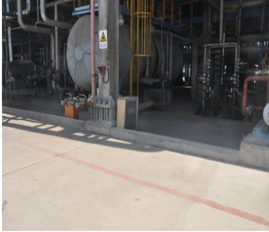
生产装置区围堰设置情况
