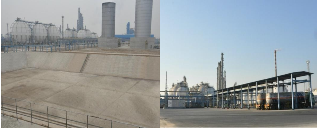
事故水池防渗措施
