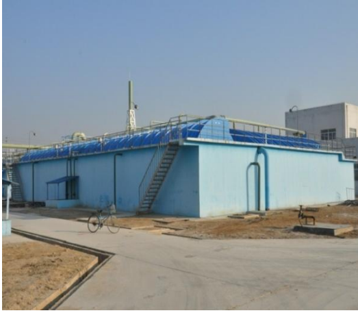
污水处理组合水池一
